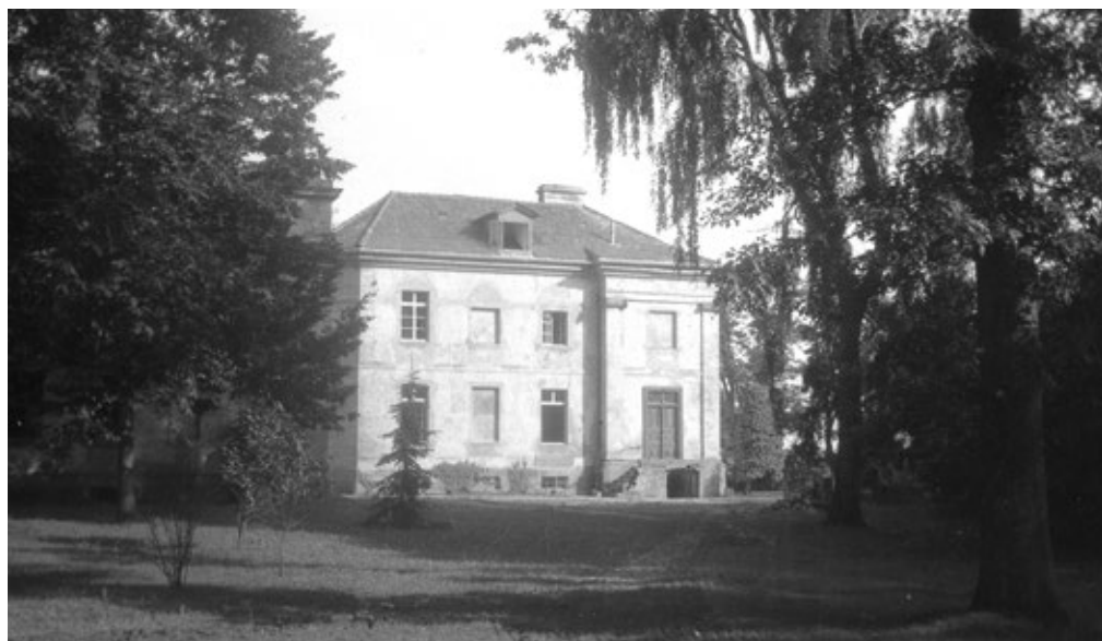
Il. 21. Nawra, pałac, elewacja boczna zachodnia (północno-zachodnia), ok. 1940– 1941 r. (zdjęcie ze zbiorów prywatnych A. Szczanieckiego).
