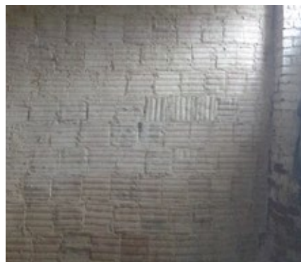
Il. 19. Nawra, pałac. Wtórne ścianki dostawione z cegły dziurawki w latach 40. XX w. Fot. K. Zalewski.
