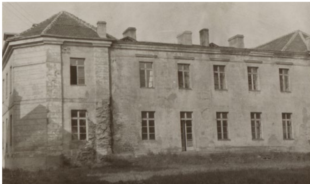
Il. 20. Nawra, pałac, elewacja północna (północno-wschodnia), 1957 („Pałac w Nawrze. Woj. bydgoskie, pow. toruński”, oprac. J. Frycz, Toruń 1957, mps, dokumentacja naukowa opracowana do użytku PP PKZ Oddział w Toruniu, mps w zbiorach WUOZ w Toruniu, sygn. W/2850, il. 37).
